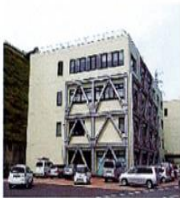
外壁の筋交いを設置した旧事務棟 震災時には事務棟として使用していた
