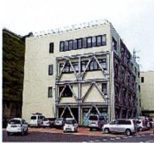
外壁の筋交いを設置した旧事務棟 震災時には事務棟として使用していた
