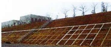
2号機建設時に9.7mの高さまで コンクリートで補強した敷地法面（縦線例示） 震災時の津波にも耐えることができた
