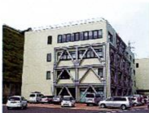
外壁の筋交いを設置した旧事務棟 震災時には事務棟として使用していた
