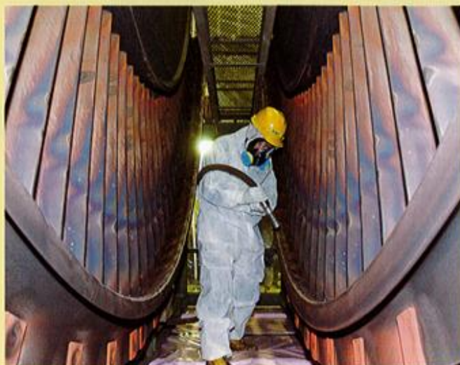
▲高圧洗浄機でタービンにプラストを吹き付ける(作業イメージ)
