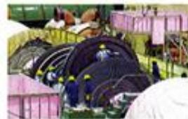
タービン設備の分解点検
