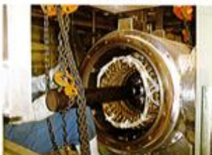
格納容器内の除湿・冷却用設備 本格点検工事
