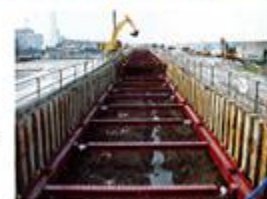
▲水路敷設箇所の地盤掘削
