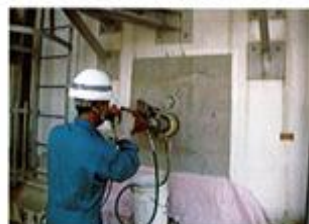
原子炉建屋壁の健全性確認 (試料採取作業)
