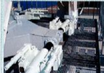
▲主排気筒に取り付けられる制震ダンパー
