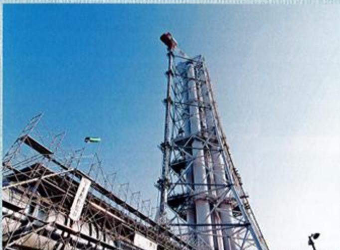
▲発電設備から換気される空気はモニターで放射線を監視しながら主排気筒から放出されます
