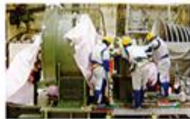
発電設備の分解点検
