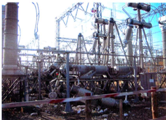
遮断器O-41 いわき幹線1L 損傷状況
