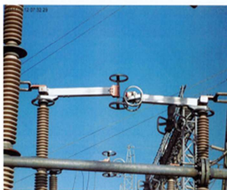
(8) 断路器33 大熊線3L 損傷状況
